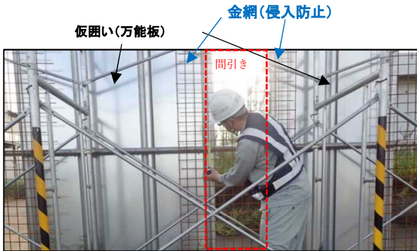
写真：臨機の措置状況（間引き等）
