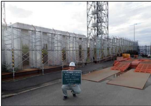
写真：臨機の措置完了
