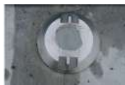
写真 2-1 電位測定端子
