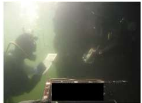
写真 2-3 潜水目視状況
