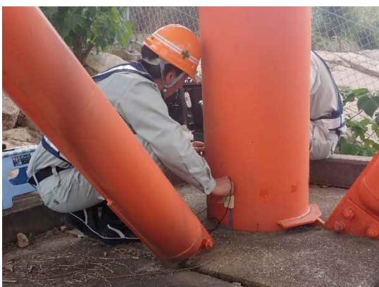
トレスル橋脚 非破壊試験状況
