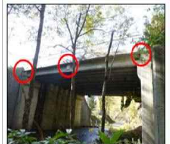
※地覆水切りが上床版までの打ち下ろしのため、横桁位置が確認できる。
