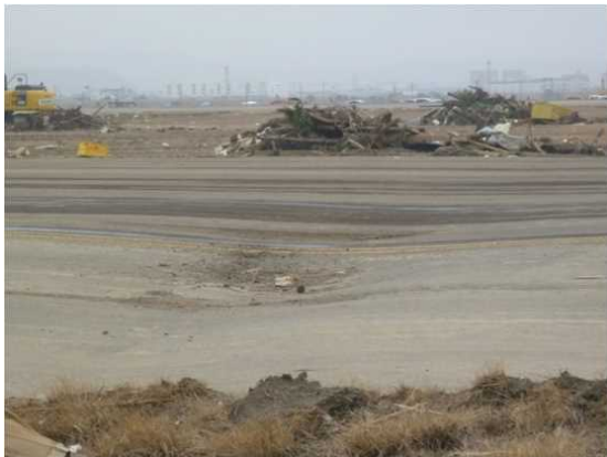
写真－2. 2 【基礎地盤の液状化による局所沈下】の例 (誘導路本体と誘導路ショルダーの境界の路面標識に乱れがある)
