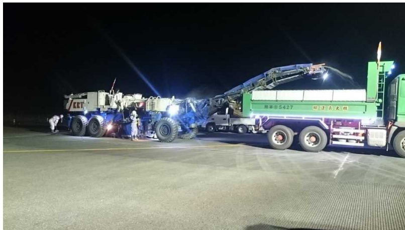
写真－4. 1 路面切削機（これは大型であるが、中型・小型もある）
