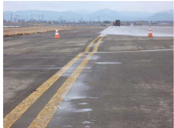
写真－2. 2 【基礎地盤の液状化による局所沈下】の例 (誘導路本体と誘導路ショルダーの境界の路面標識に乱れがある)
