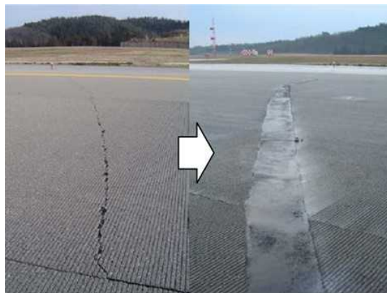
図－4. 2 ゼロ摺り付けによる応急復旧の例（2007年能登空港）
