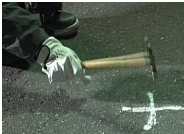
写真 4.2.2 打音調査の状況
