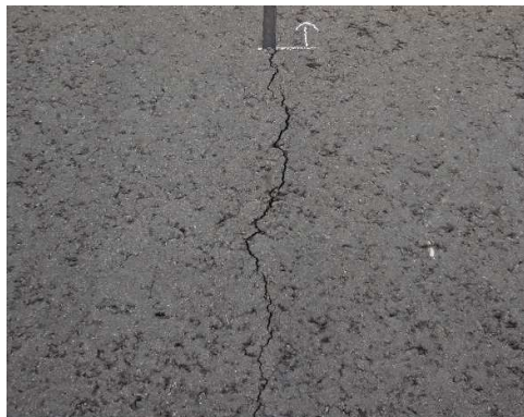
写真3.1.5 リフレクションクラック
