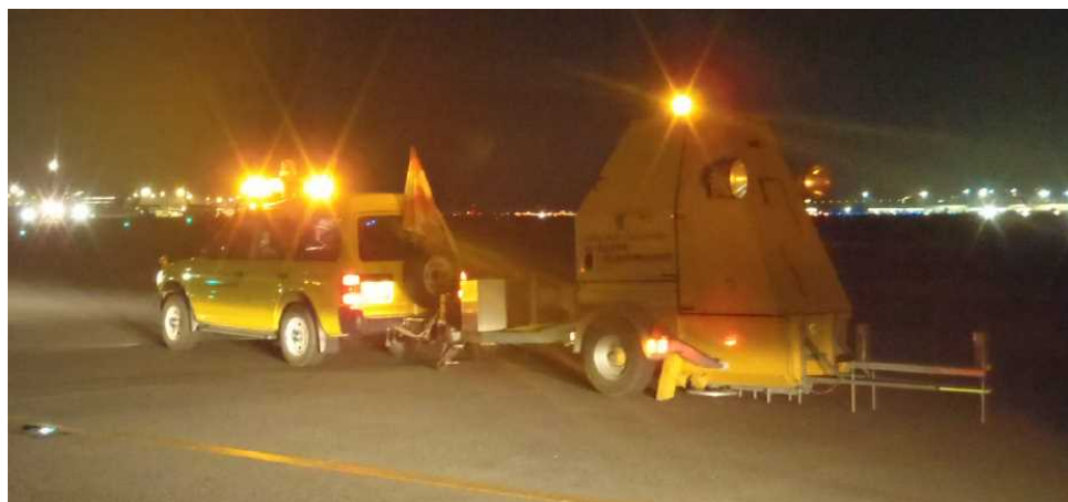
写真 4.5.2 FWD調査の状況（例）
