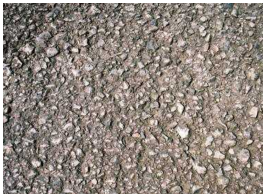
写真 3.1.11 路面の荒れ
