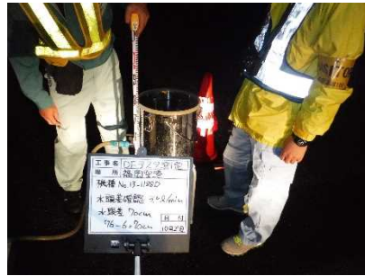
水頭差現地確認
