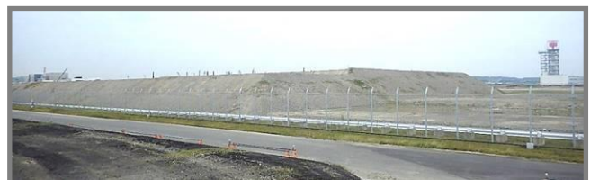
(写真-6) 載荷盛土状況②
