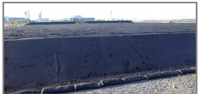
(写真-5) 載荷盛土状況①
