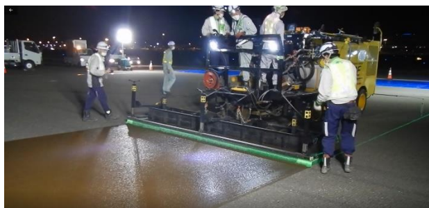
写真-5 専用施工機による塗布状況
