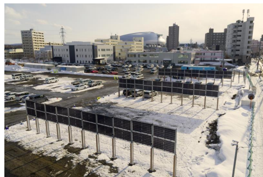
図-8 垂直型ソーラーパネル“VERPA”
