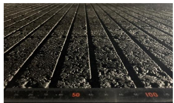
写真-6 グルーピングの仕上がり (B 滑走路)
