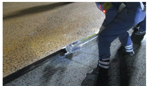
写真-4 L型止水テープ設置状況 (AB クロス)
