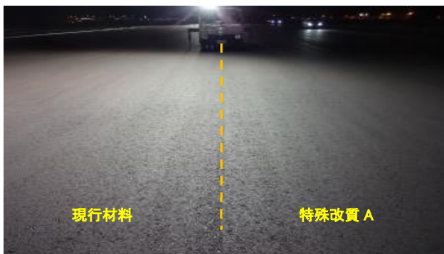
写真-3 施工後の仕上がり (AB クロス)
