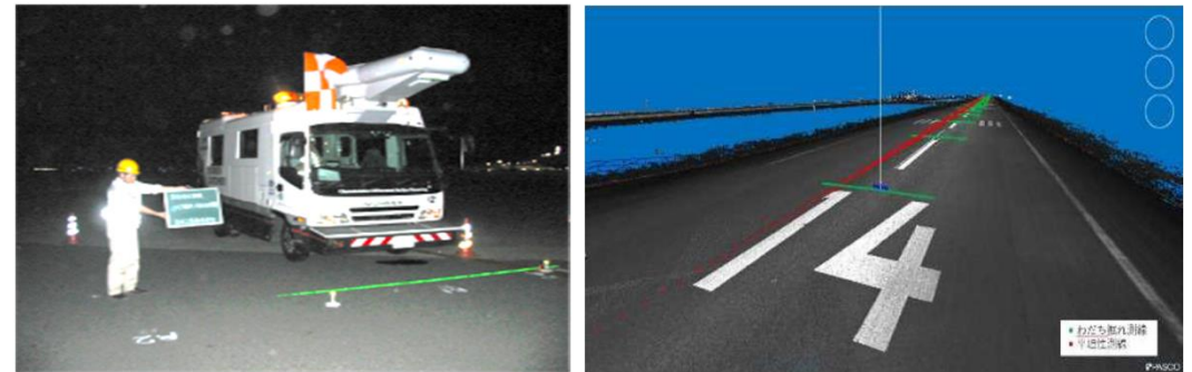
＜MMS車両による路面性状調査・定期点検測量＞【導入済み】
