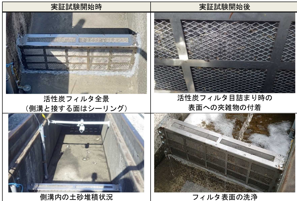
例 図-1 令和3年度実証試験時の現地状況（松山空港）
