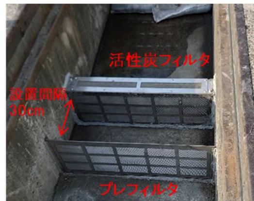
例 図-9 設置状況
