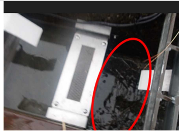
設置後 2 週間 (12/22) 時点 左：夾雑物がプレフィルタ上流で捕捉されている様子 右：本体フィルタを通水している様子
