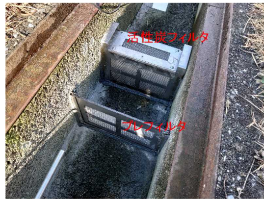
例 図-5 設置状況
