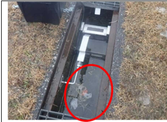
設置後 2 週間 (12/22) 時点 左：夾雑物がプレフィルタ上流で捕捉されている様子 右：本体フィルタを通水している様子
