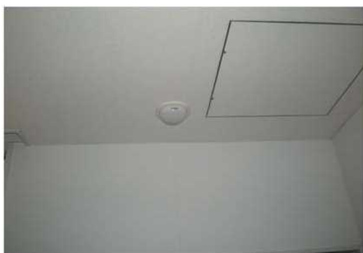
■ 人感センサーを利用した照明の自動点灯
