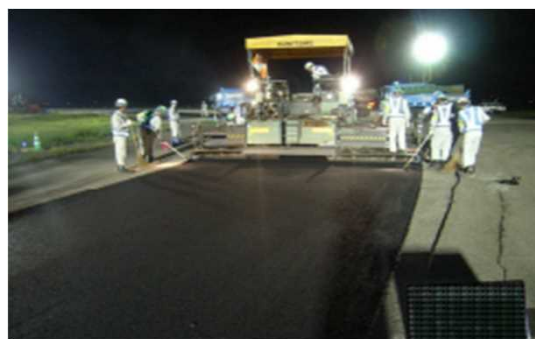
○As舗設状況
