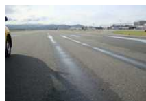
＜わだち掘れ＞ 航空機の車輪が集中して通過する位置に生ずる延長方向に連続したへこみ
