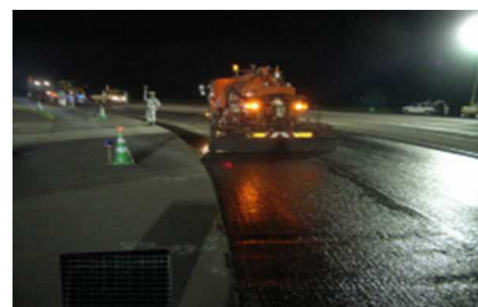
○乳剤(タックコート散布状況)
