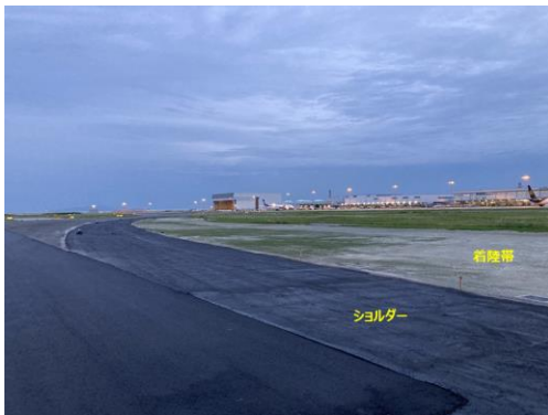
図-18 ショルダー・着陸帯嵩上げ状況
