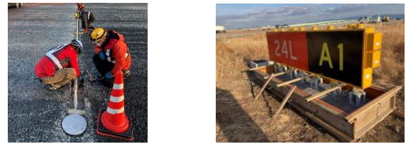
図-19 航空灯火工事 施工状況
