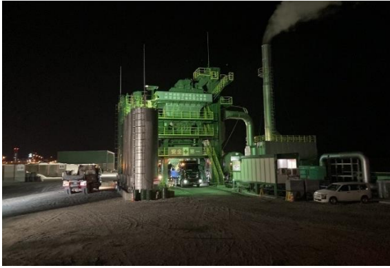
図-3 仮設アスファルトプラント
