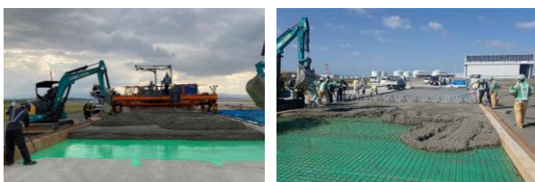
図-12 コンクリート舗設状況
