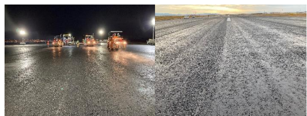
図-9 大粒径アスファルト混合物 施工状況
