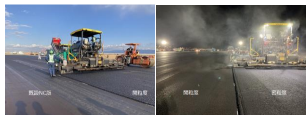
図-15 コンポジット舗装施工状況
