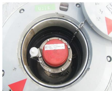
ハイドラントピットと内部のH/V
