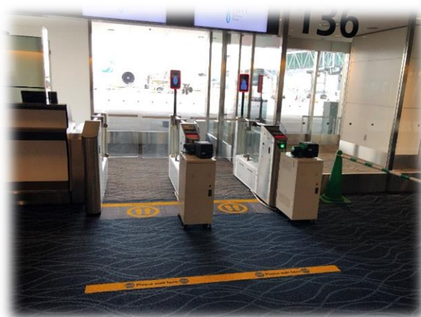
施工写真 (GATE #136)
