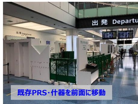
工事エリア 旅客動線を確保
