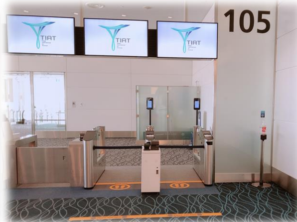
施工写真 (GATE #105)
