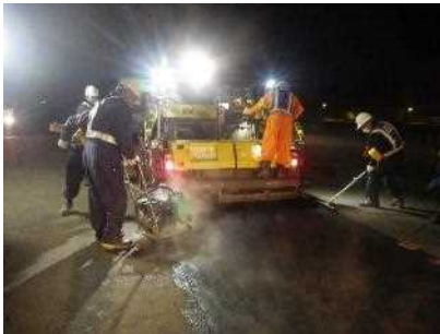
写真- 7 施工状況
