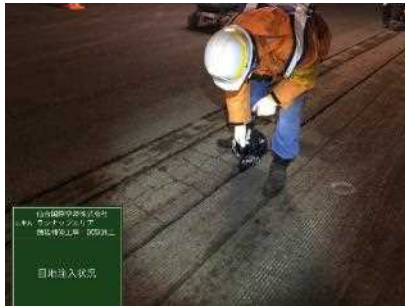
写真- 5 目地注入
