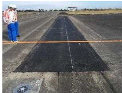
写真- 8 施工後状況
