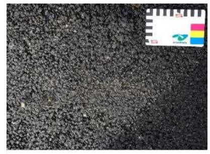
写真- 9 舗設後表面
