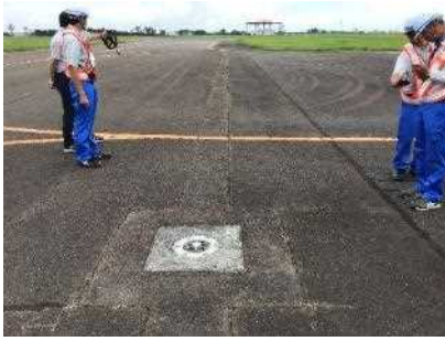
写真- 4 施工前状況
