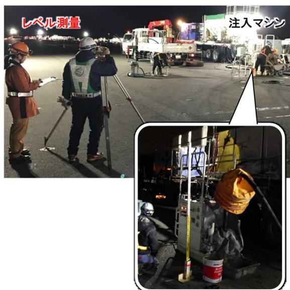
図-3 レベル測量による計測管理
