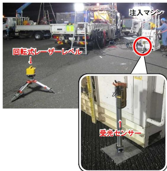
図-4 ワイヤレス沈下・隆起計測システムによる計測管理
