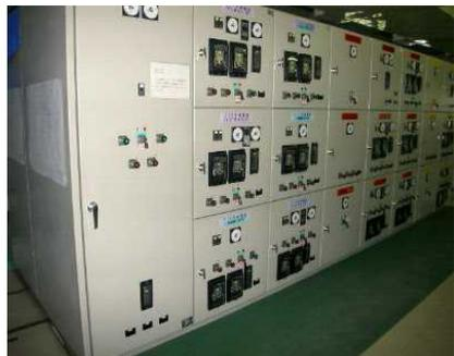
電力会社から商用電源を受電し、各設備に必要な電力を配電
