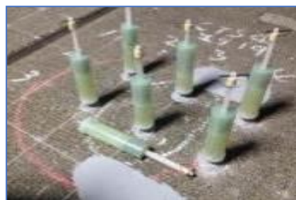
写真-10 樹脂注入
