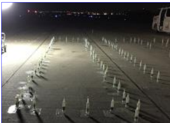
写真-7 樹脂注入状況
