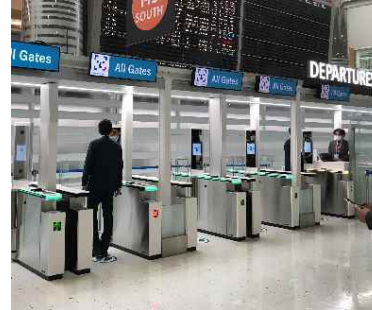
保安検査場自動ゲート
