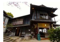
空き家群を面的に再生し活用（広島県尾道市）
