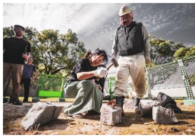
熊本城における石垣修復ガイドツアー
