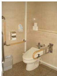
④多機能トイレの整備
