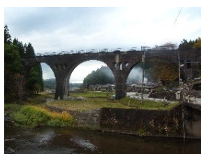
歩道化された線路跡や 橋梁
