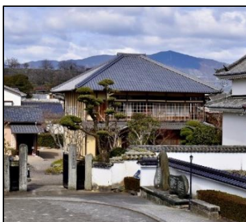
国指定登録文化財を改修・活用したMITI棟(村上家住宅)・2021年4月開業。
