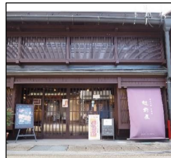
越前屋の外観。中には展示スペースや住民が利用可能な多目的スペース等がある。
