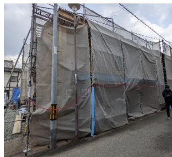
3期物件改修工事の様子。隣り合う物件を一度に改修することによりコスト削減および動線の確保を行っている。
