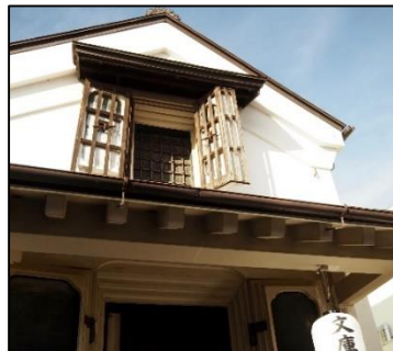
蔵を改修して作られた客室
