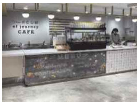
土産物店・飲食店等の改修
