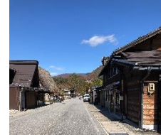
↑電線のない景観、景観に配慮した自販機 ↓景観を損ねる建物(A9,B6,C1)
