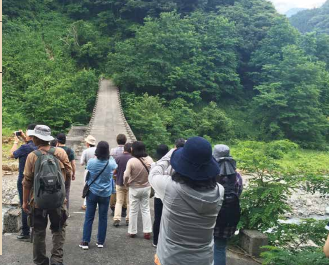
石坂 浦川スーパー暗渠砂防堰堤
