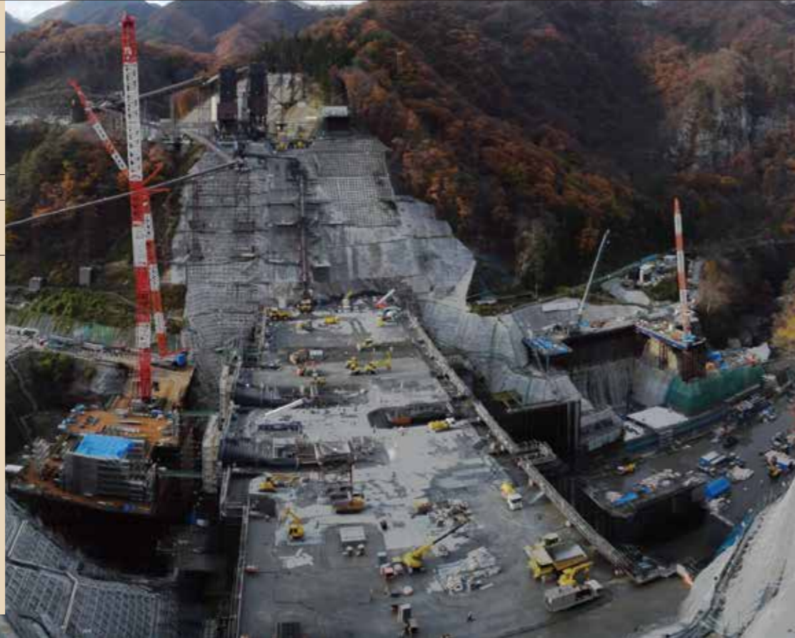
工事現場(ダム上部より)
