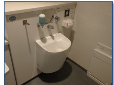
▲オストメイト対応設備
