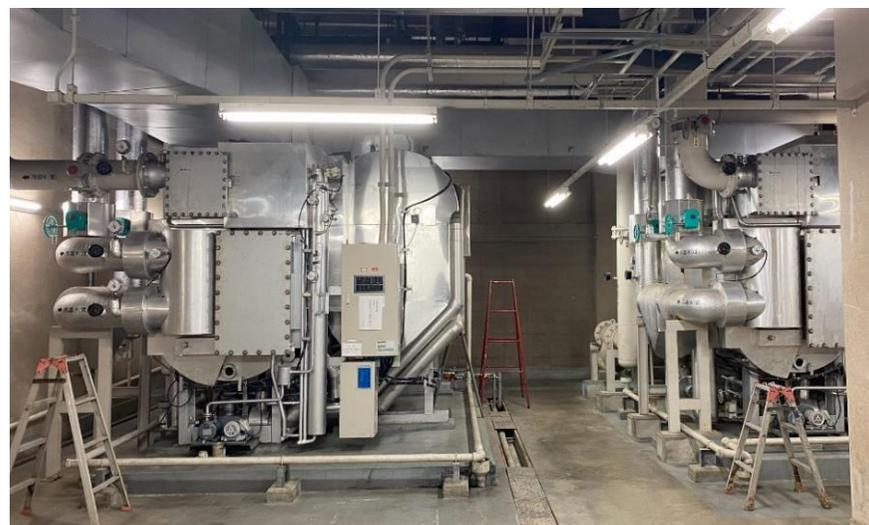
中央式空調 熱源:直焚吸収冷温水機(灯油)
