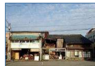
空き家の除却
