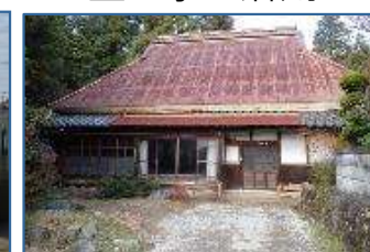
空き家の活用
