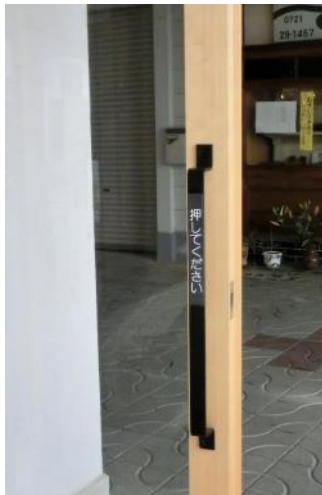
開閉表示を設置
