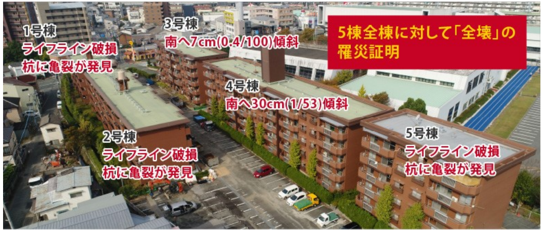
被災状況①
