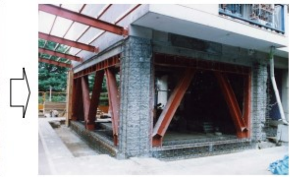
（工事中の写真）
