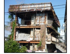
行政代執行により除却したマンション
