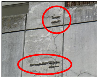
躯体(鉄筋)の爆裂
