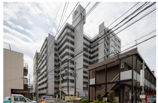
再建マンションの外観
