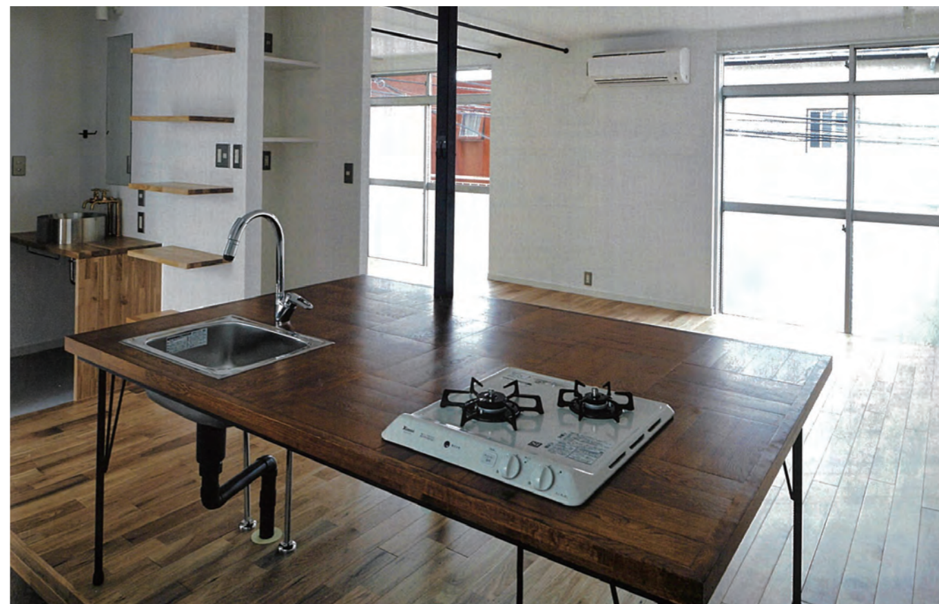
改修後の室内 [間取り変更、水回り設備交換、床・壁・天井材貼替え]
