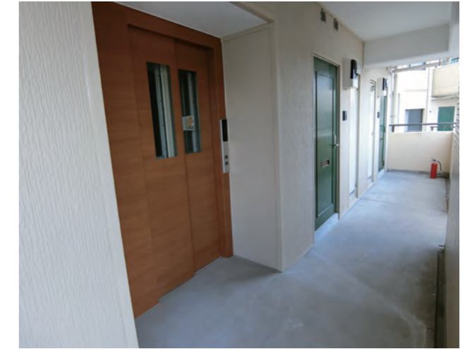
工事後の共用部
