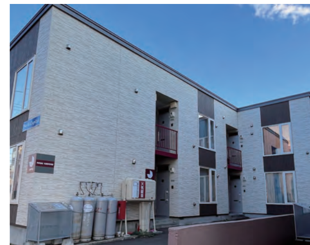
改修後の外観 [外装材全面貼替え]
