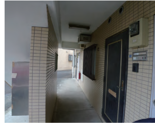
工事前の共用部
