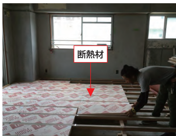
床に断熱材を敷き詰めている
