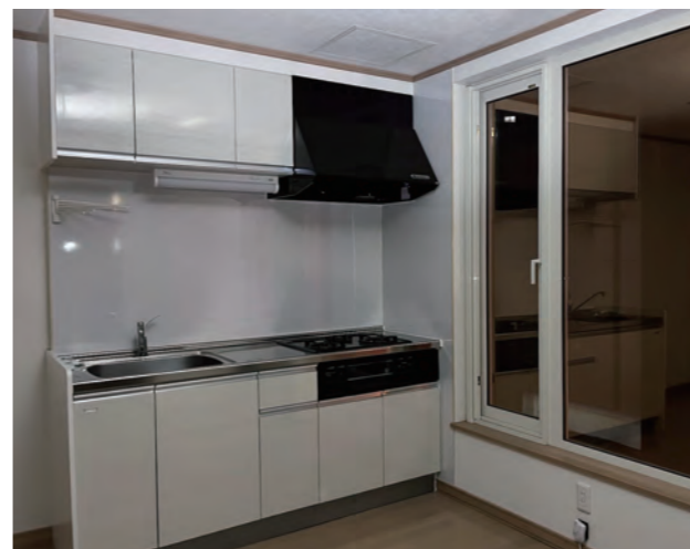
改修後の室内 [キッチン設備交換、開口部サッシ交換]
