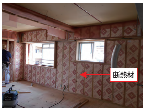
壁に断熱材を充填した状態
