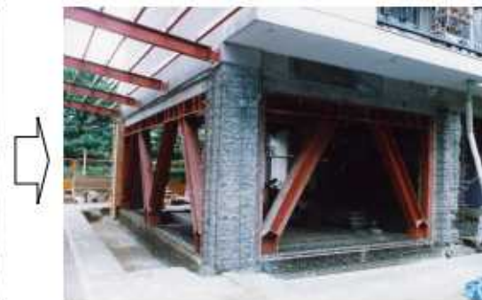
(工事中の写真)
