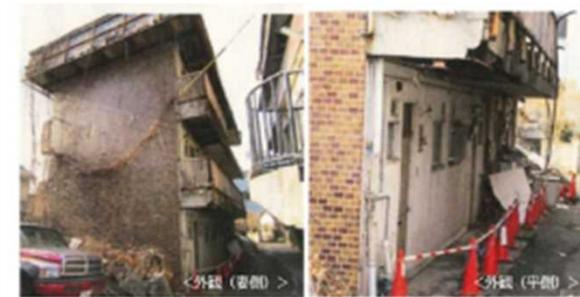
外壁、手すりが崩落した事例
