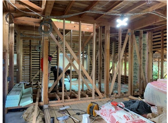
写真7 改修工事の状況②
