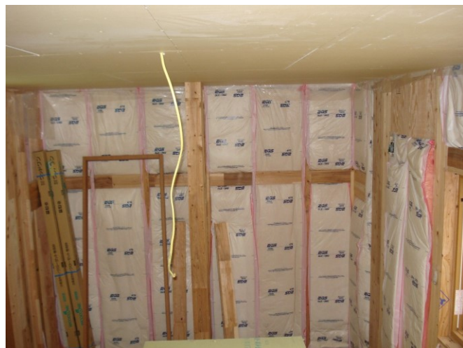
新築時の断熱施工の確認事例
