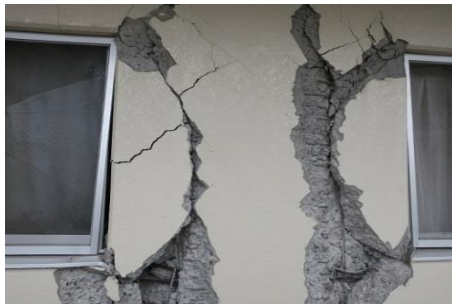
熊本地震における非構造壁の損傷
