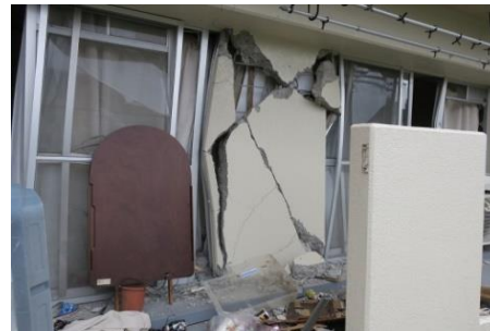
熊本地震における非構造壁の損傷
