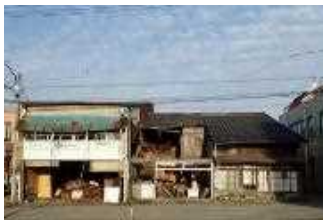
＜空き家の除却事例＞
