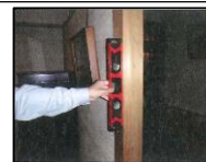
水平器による柱の傾きの計測
