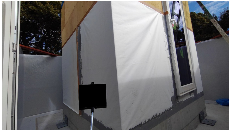
外壁部試験体の一例
