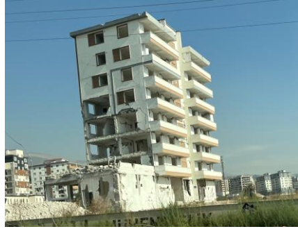
被災地視察（ガジアンテップ～カフラマンマラッシュ）
