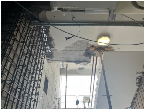
被災地視察（ガジアンテップ～カフラマンマラッシュ）
