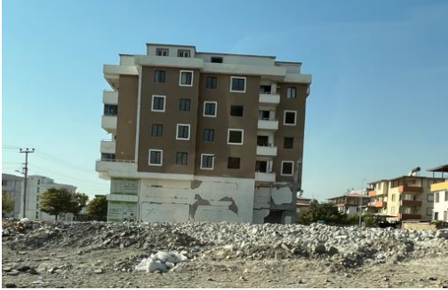
被災地視察（ガジアンテップ～カフラマンマラッシュ）
