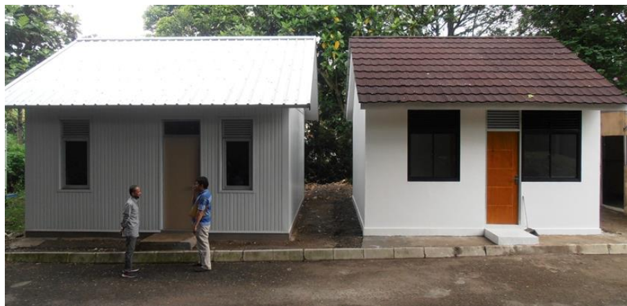
【図 2-7 試作棟 右:異形コンクリートブロック工法、右:LGS パネル工法】
