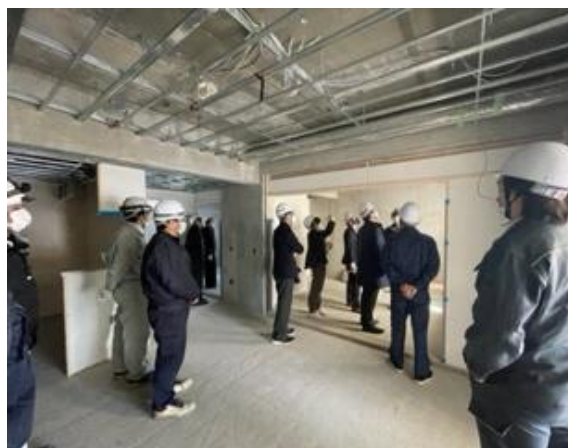
施工現場の見学
