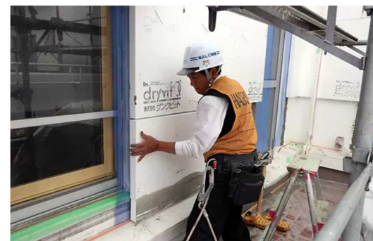
断熱材（厚さ50mm）を外壁に貼り付け
