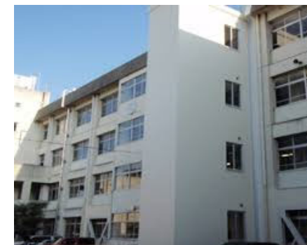
既存校舎に増築したエレベーター棟
