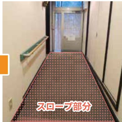
客室をバリアフリー改修 する際、客室内の水廻り の段差を客室外の廊下 (スロープ)で解消しました
